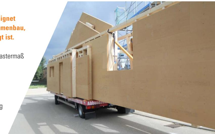
Ideal für die Vorfertigung: Wandbeplankung und Dämmung für hinterlüftete Fassaden
