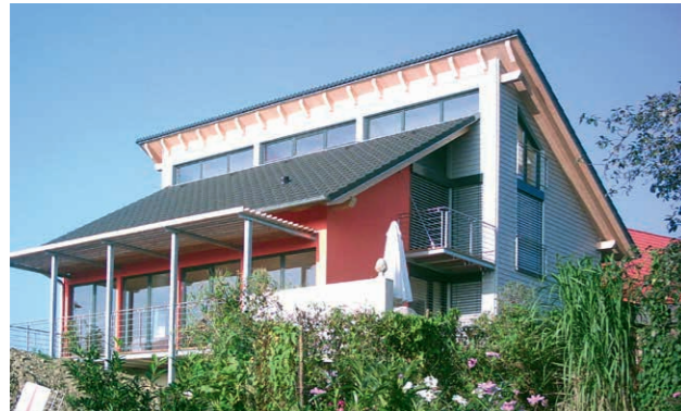
Surface habitable: 150 m 2 | Durée du chantier: 12 semaines
