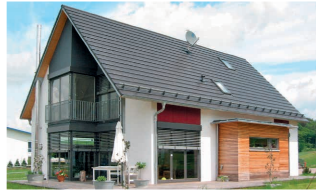
Surface habitable: 167 m 2 | Durée du chantier: 10 semaines
