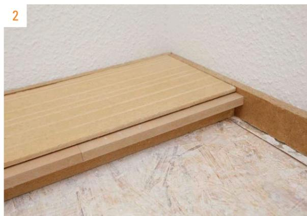
Passgenaue und fugendichte Verlegung der AGEPAN® TEP
