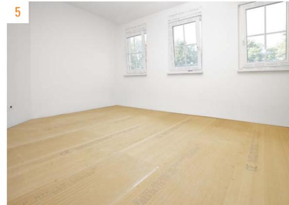
Vollflächig verlegte AGEPAN® TEP als Untergrund für diverse Oberbeläge
