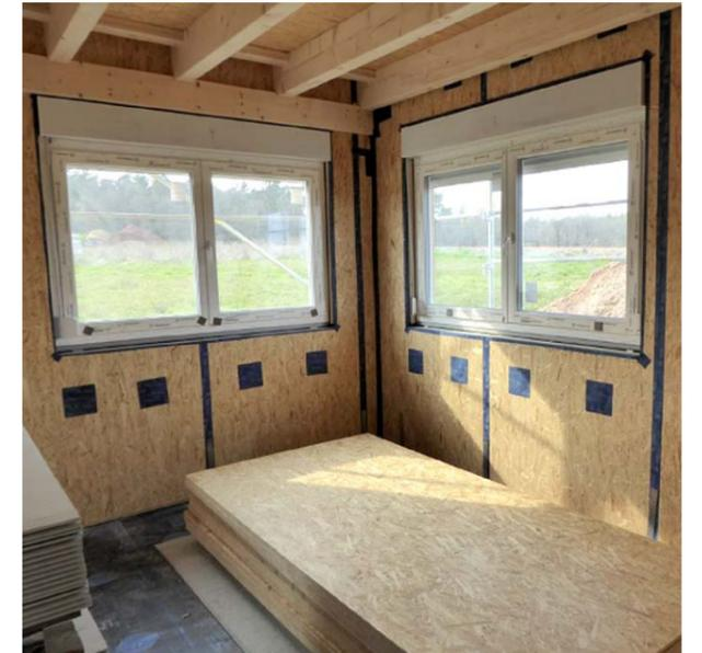
Dieses Bild zeigt eine mit AGEPAN® OSB Ecoboard® hergestellte luftdichte Ebene. Alle Anschlüsse, Fugen und Durchdringungen werden mit geeigneten Klebebändern perfekt abgedichtet.
